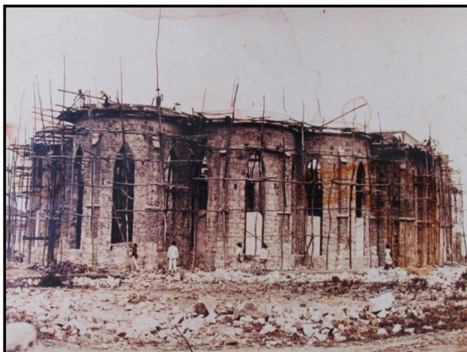
Figura 10: Início das obras da Catedral em 1926.
