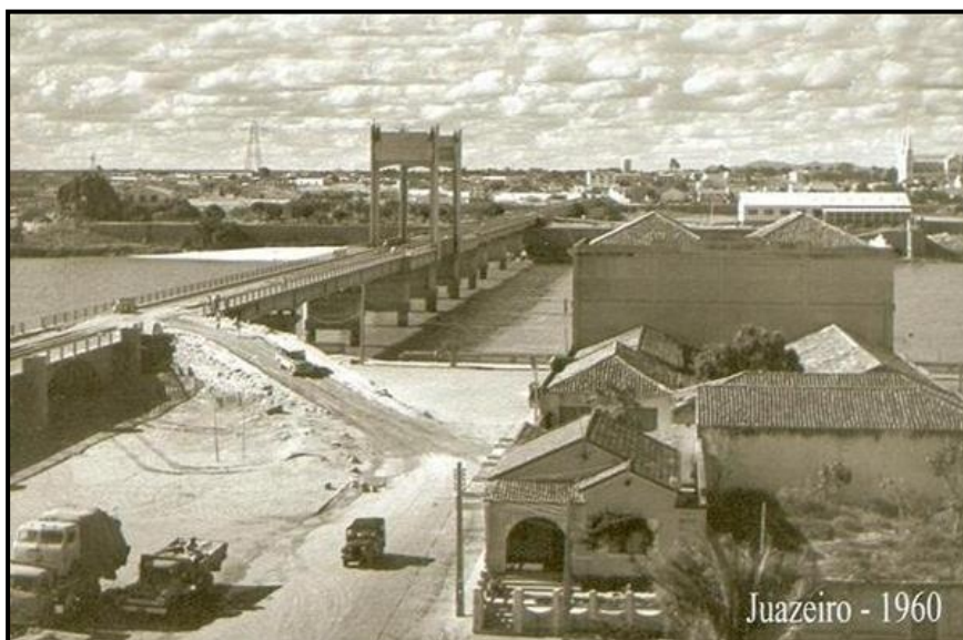
Figura 9: Acesso à ponte na década de 1960.
